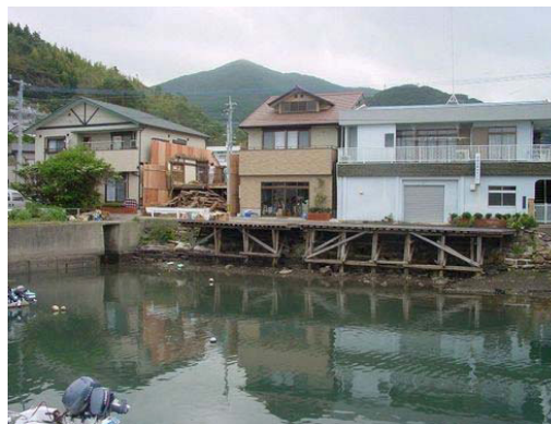
図2 解体中の当時の家屋（2004年筆者撮影）
